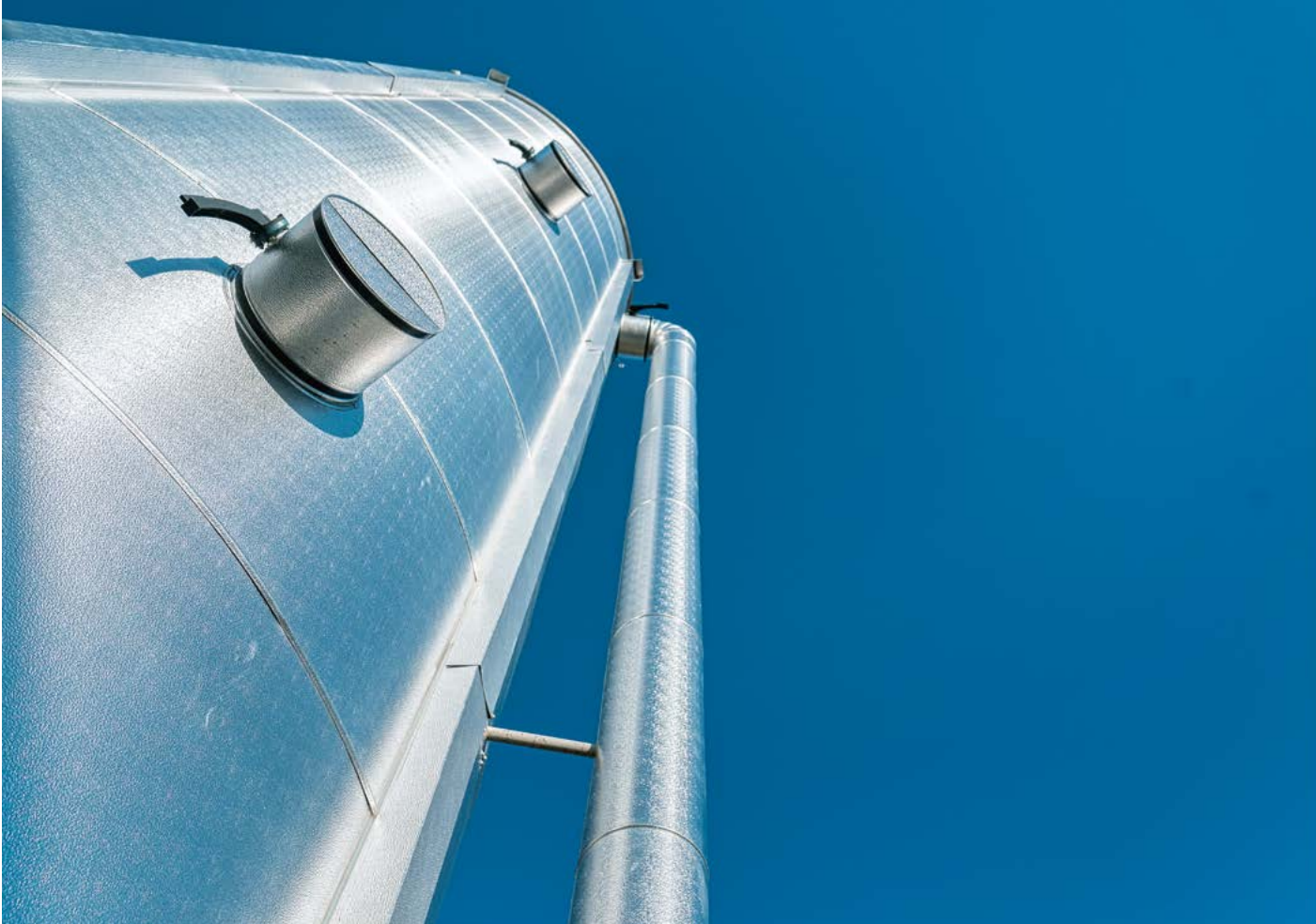
Beim Birsmattehof kommt e in Wasserspeicher mit 50 m 3 Volumen zum Einsatz.
